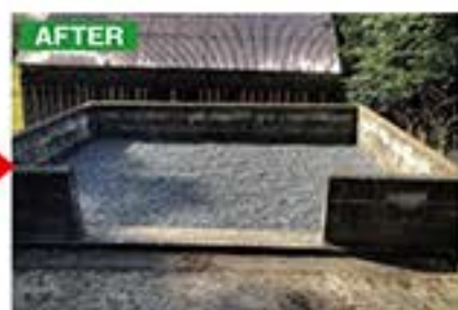
お墓を撤去し永代供養しました。
